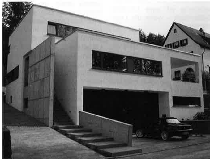
Dank einer Rampe zum rückseitigen Eingang ist das erste Wohngeschoss stufenlos zu erreichen.
